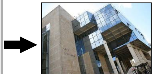
Le parcours se clôturera devant le Palais de Justice, place des Jacobins
